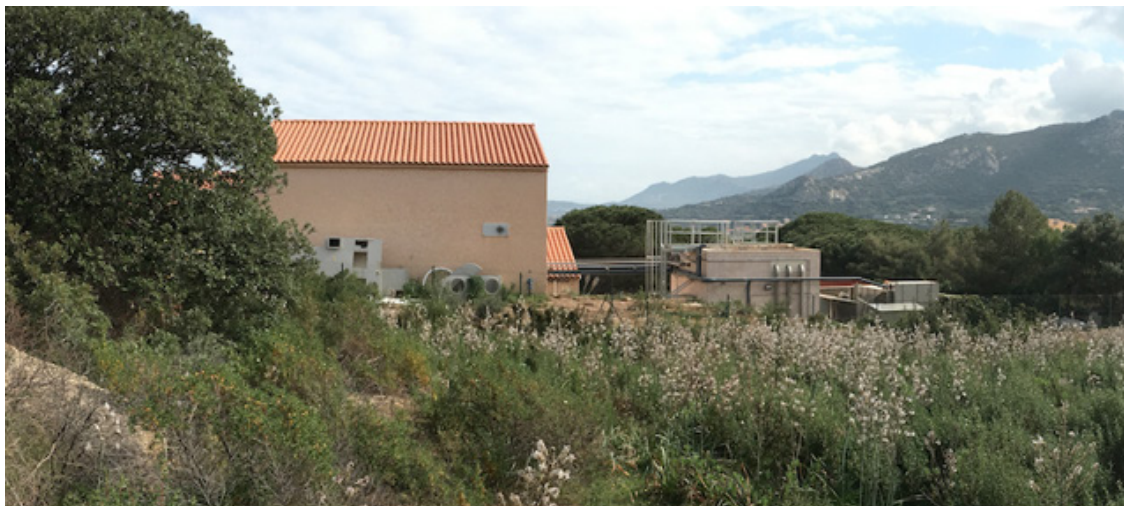
Vue de la STEP depuis le terrain
