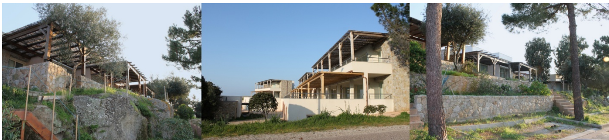
Nouvelles constructions valorisantes de la Marine
