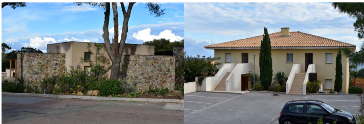
Exemple de toitures bien intégré au patrimoine balain à gauche et exemple de toiture et de volumes annexes (escaliers) entrant en contradiction totale avec le patrimoine balain.
