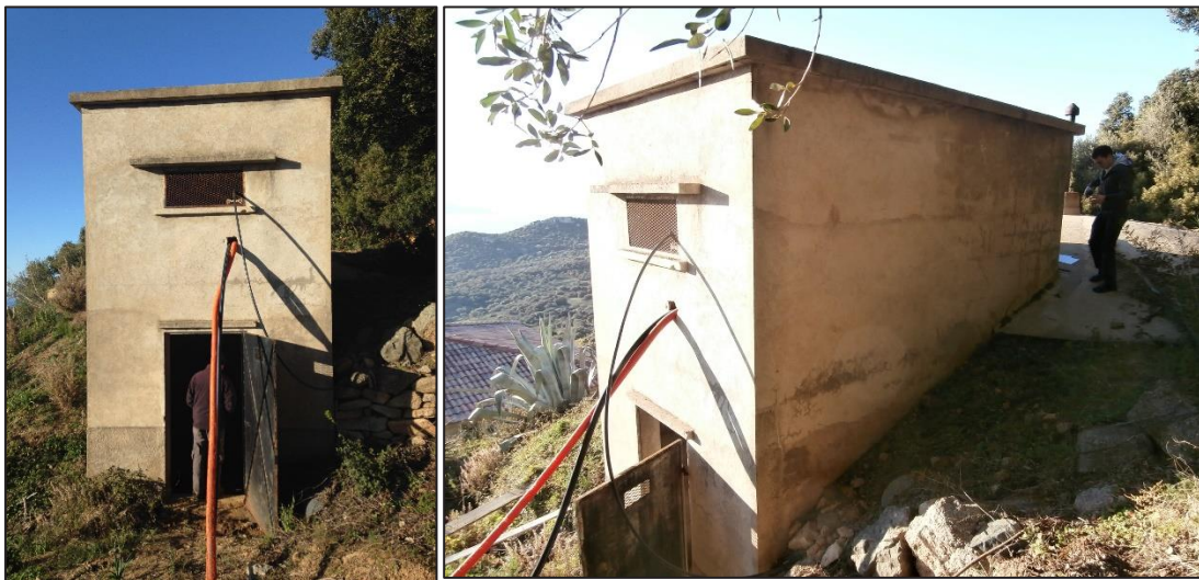
Figure 26 :Vues générales du réservoir
