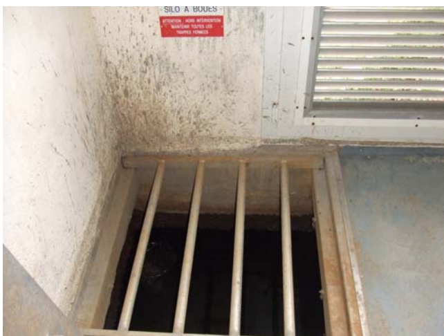
Silo à boues
