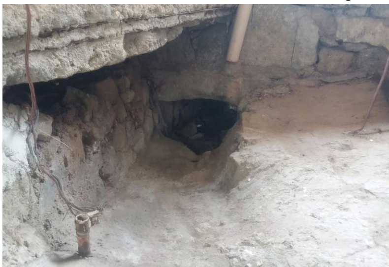
Tête amont de l'ouvrage hydraulique
