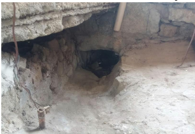
Tête amont de l'ouvrage hydraulique
