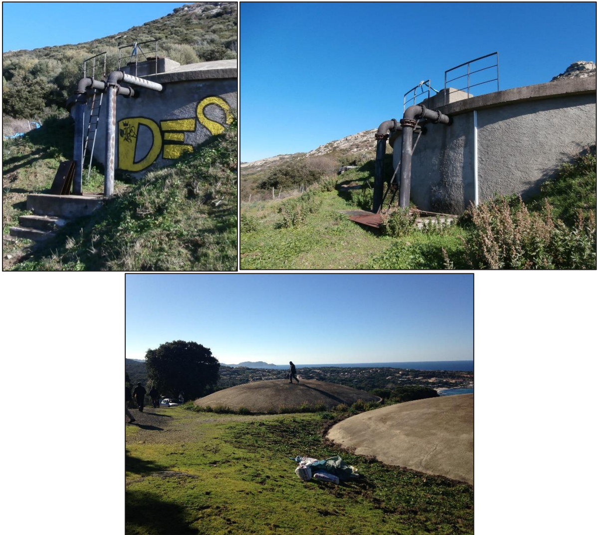
Figure 20 :Vues générales du réservoir
