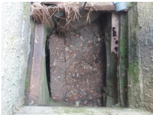
Seuil et obstruction Ø600
