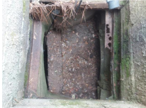
Seuil et obstruction Ø600
