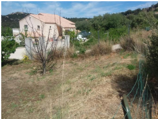
Exutoire du Ø600 enterré
