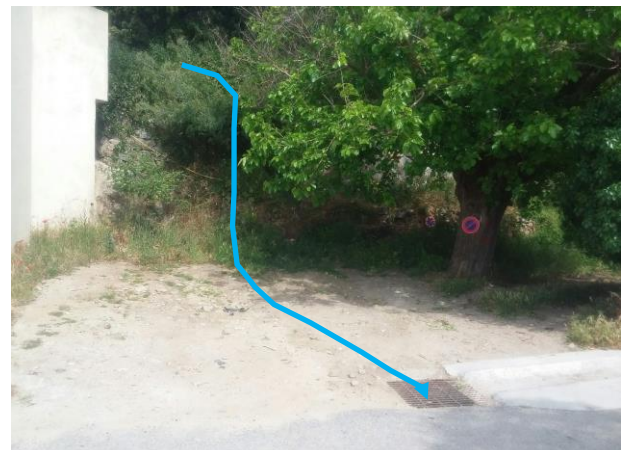
Chute d'eau et avaloir
