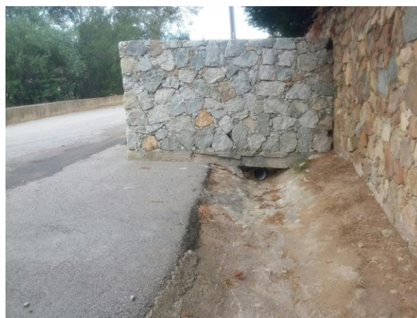
Aval local poubelle
