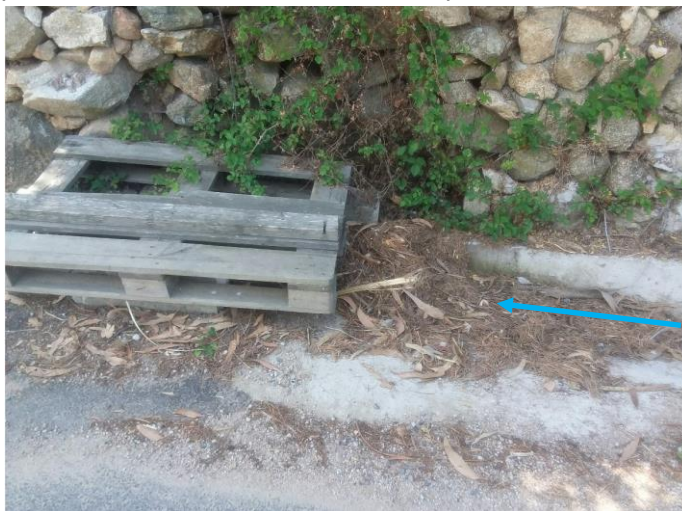
Dépôt empêchant la connexion avec le réseau enterré
