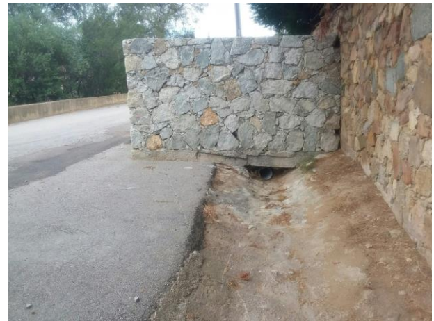
Aval local poubelle
