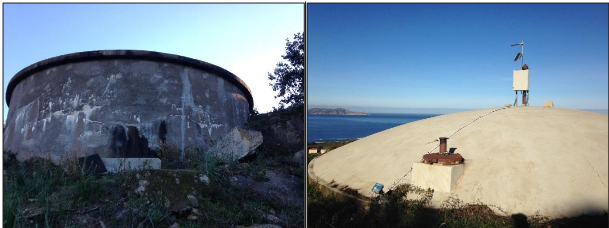
Figure 21 :Vues générales du réservoir
