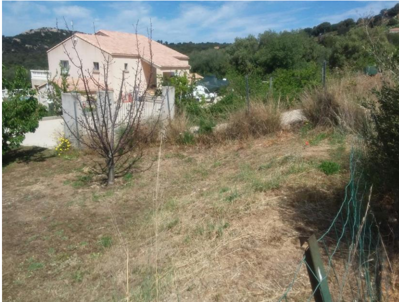
Exutoire du Ø600 enterré
