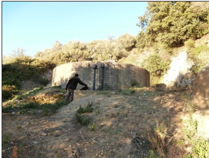
Figure 28 :Vues générales du réservoir
