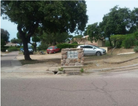
Avaloir avenue des Oliviers
