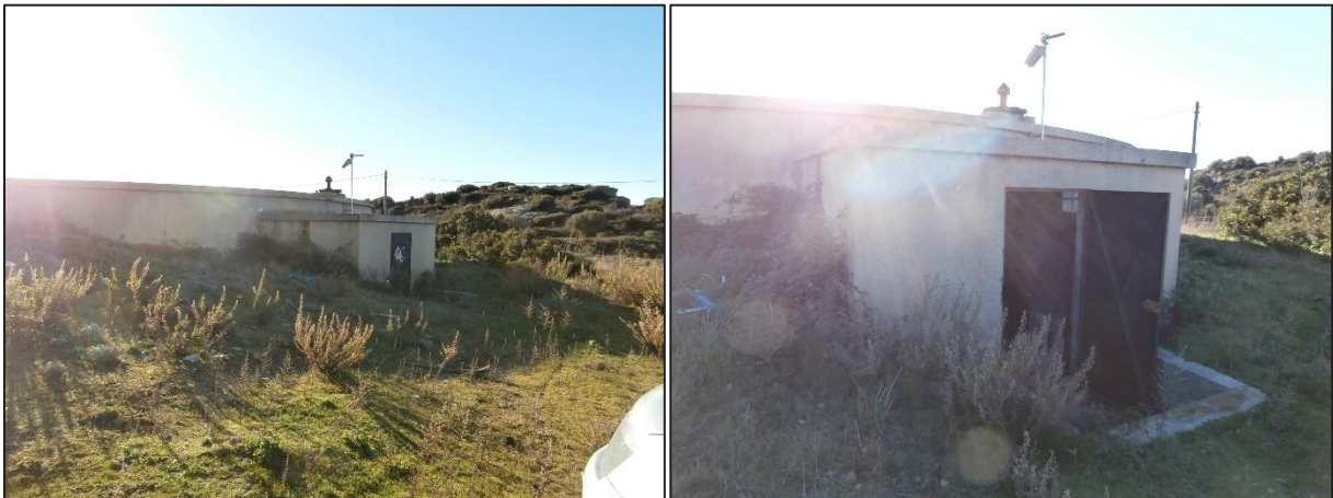
Figure 22 :Vues générales du réservoir
