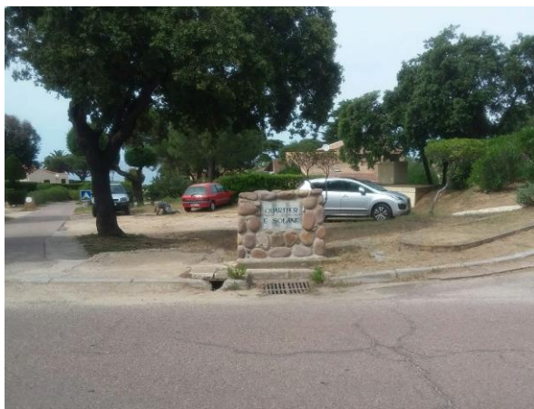
Avaloir avenue des Oliviers
