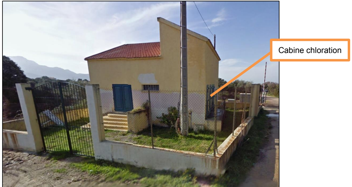
Figure 35 : Vue générale station
