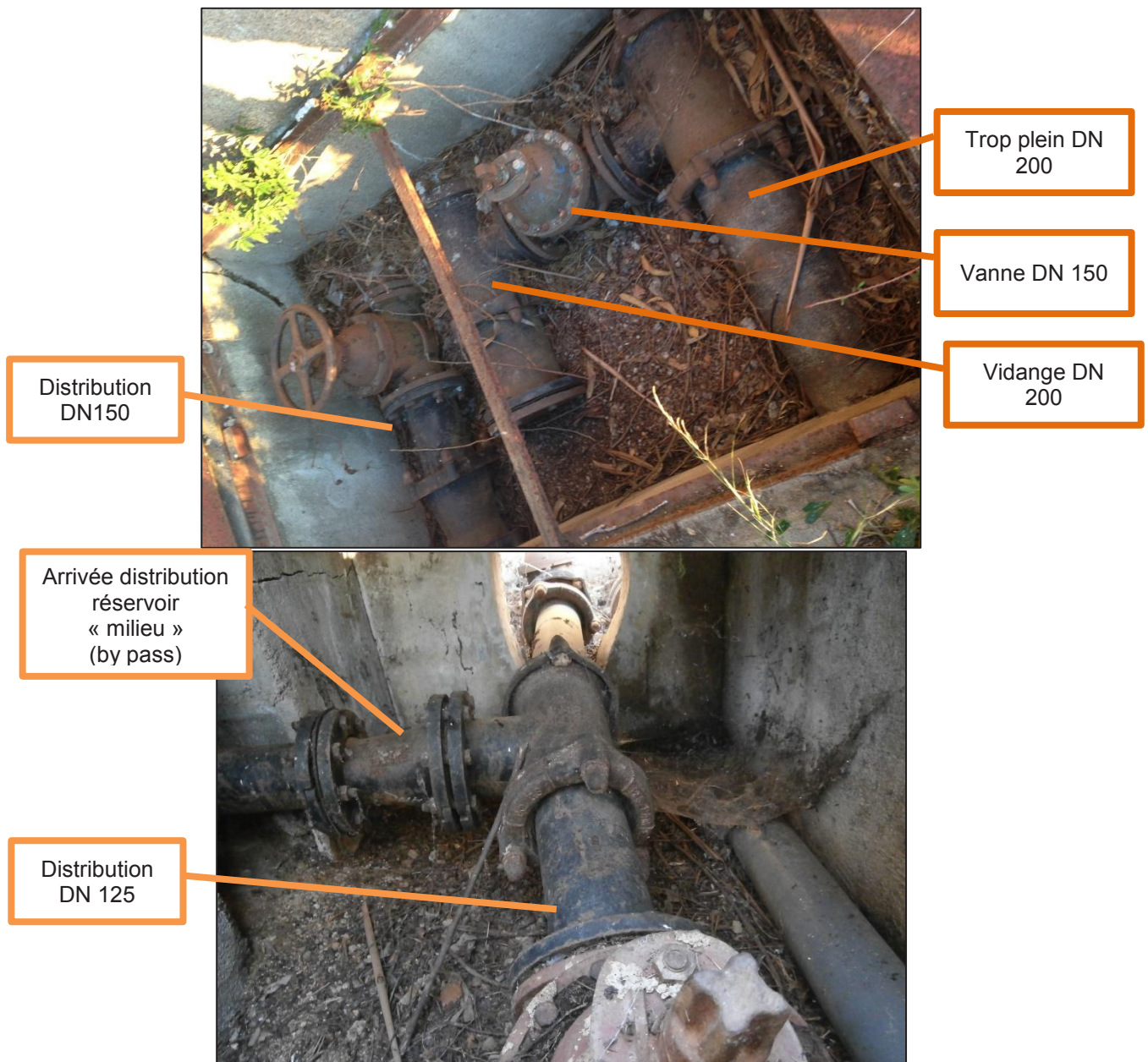
Figure 24 :Chambres des vannes avant travaux
