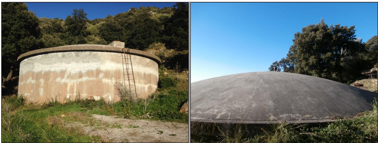
Figure 23 :Vues générales du réservoir
