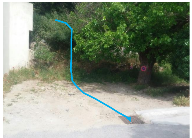
Chute d'eau et avaloir
