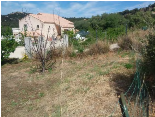
Exutoire du Ø600 enterré
