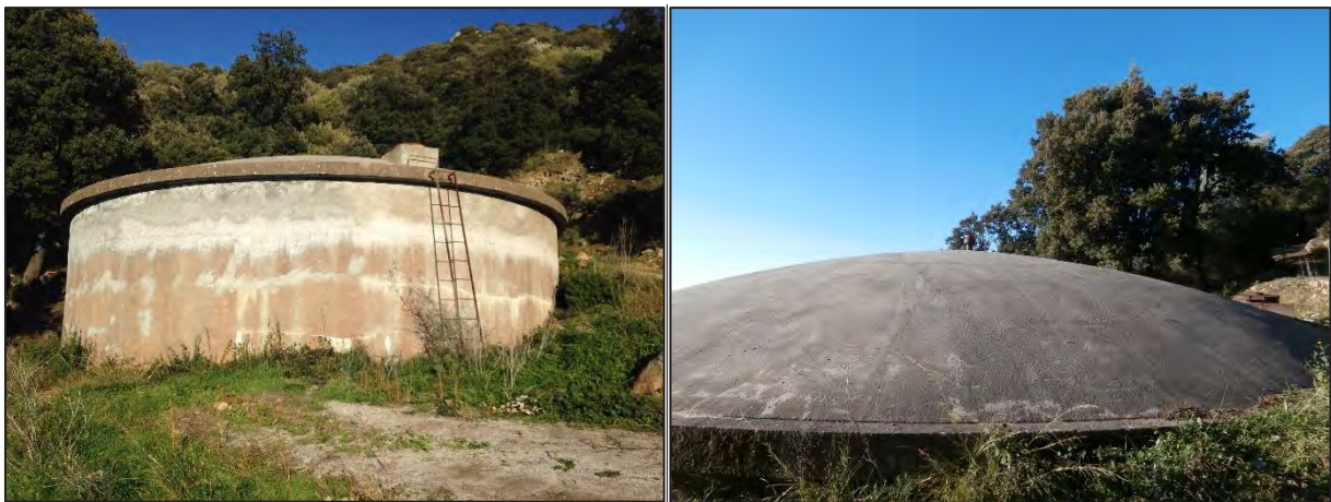
Figure 23 :Vues générales du réservoir
