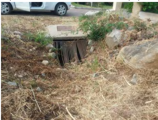
Obstruction fréquente de la grille
