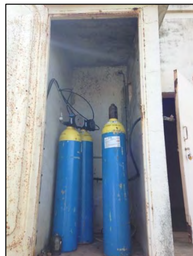
Figure 33 :Armoires de commande et cabine de stockage de chloration
