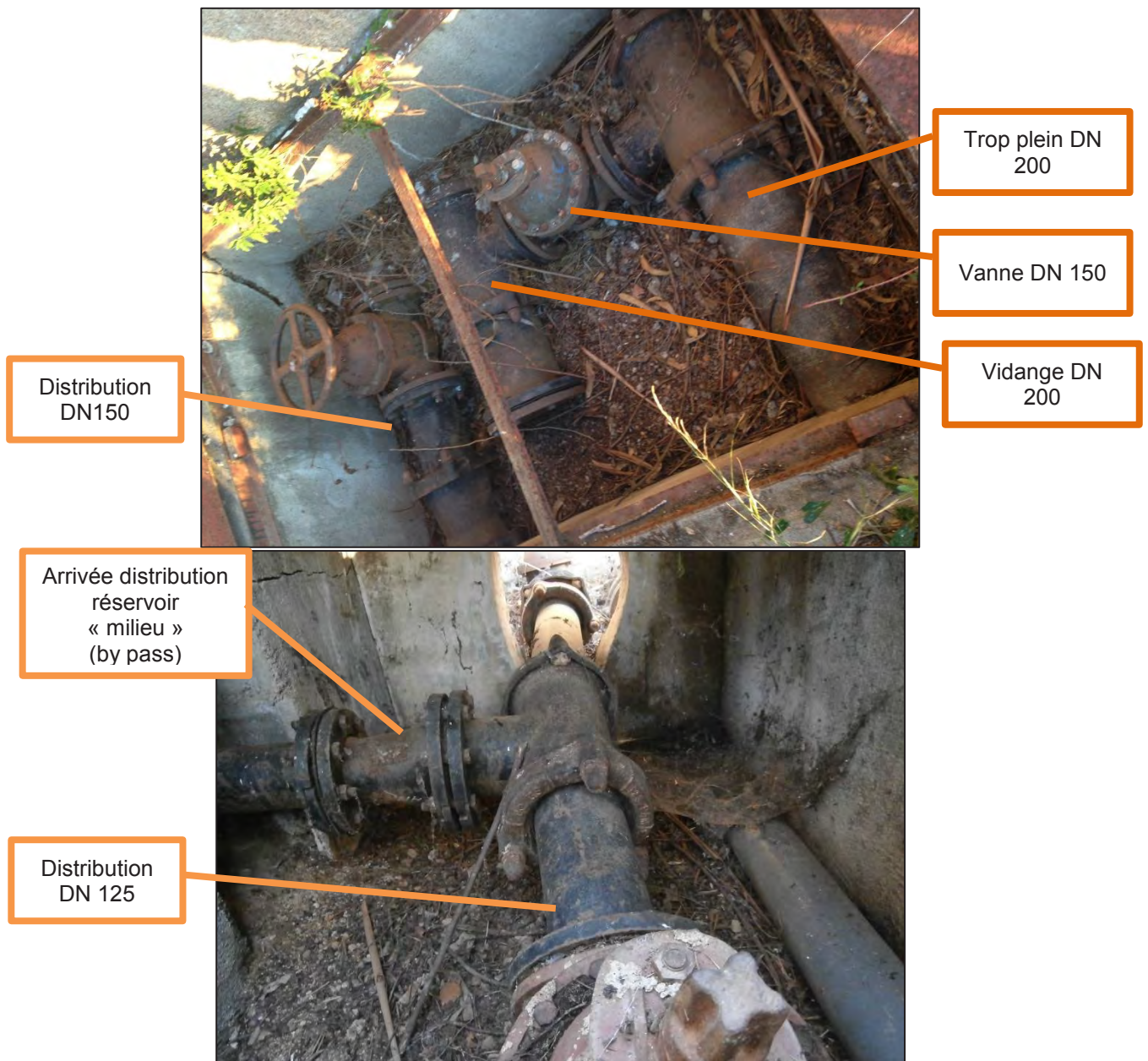
Figure 24 :Chambres des vannes avant travaux
