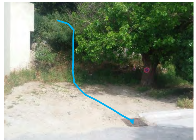
Chute d'eau et avaloir
