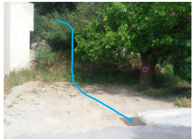
Chute d'eau et avaloir
