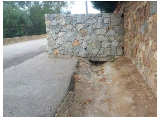
Aval local poubelle
