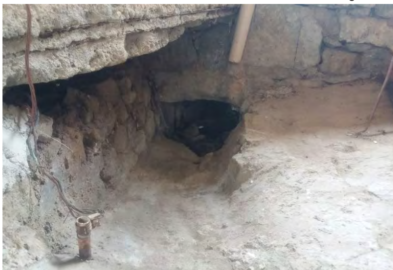
Tête amont de l'ouvrage hydraulique
