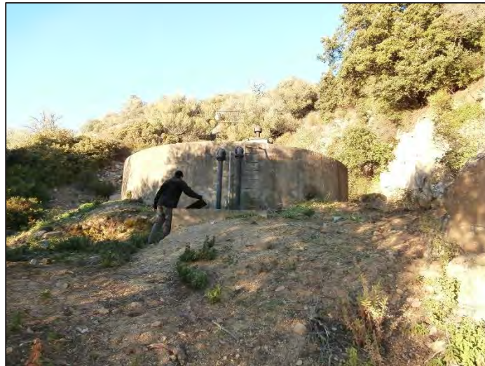
Figure 28 :Vues générales du réservoir
