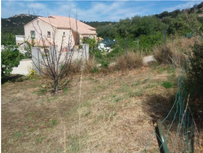
Exutoire du Ø600 enterré
