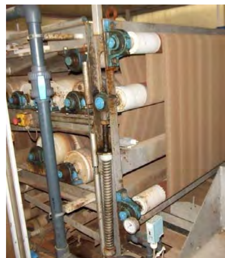
Presse à bandes (déshydratation des boues)
