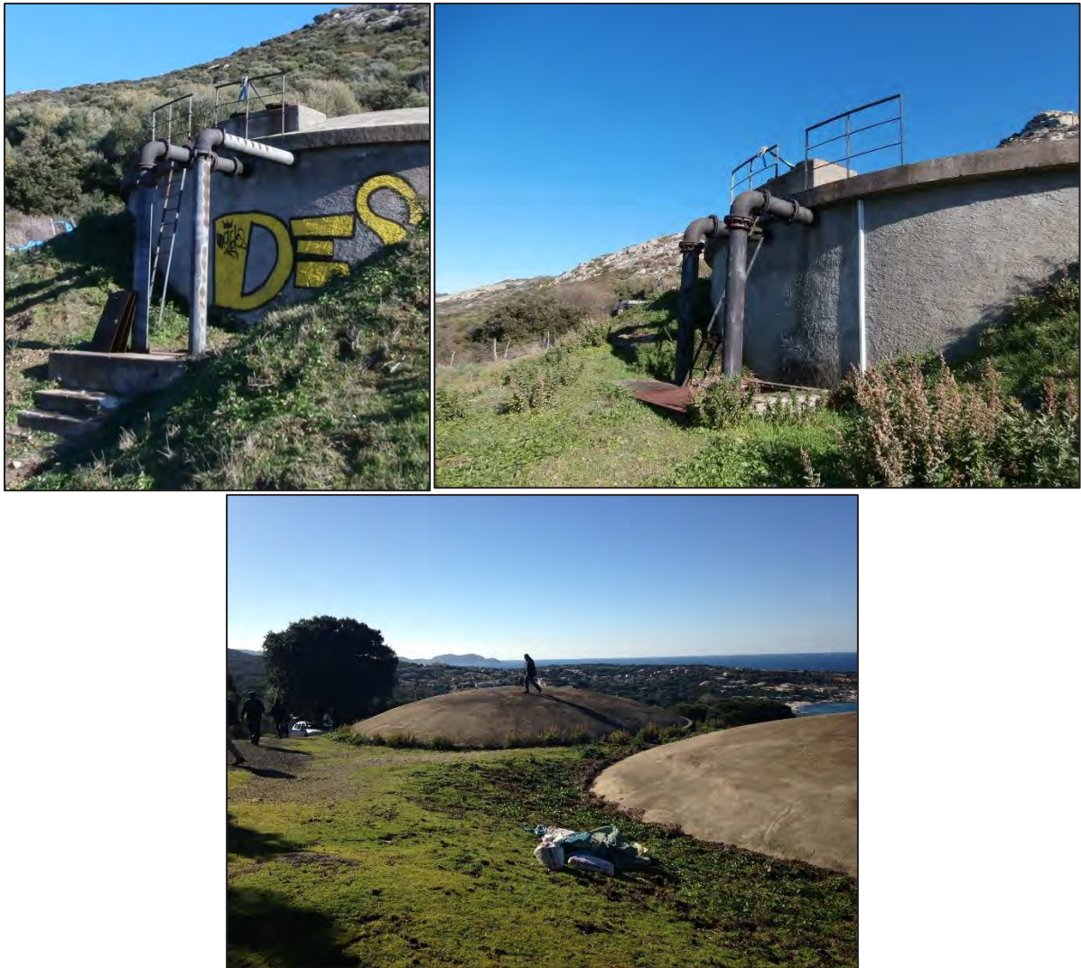
Figure 20 :Vues générales du réservoir
