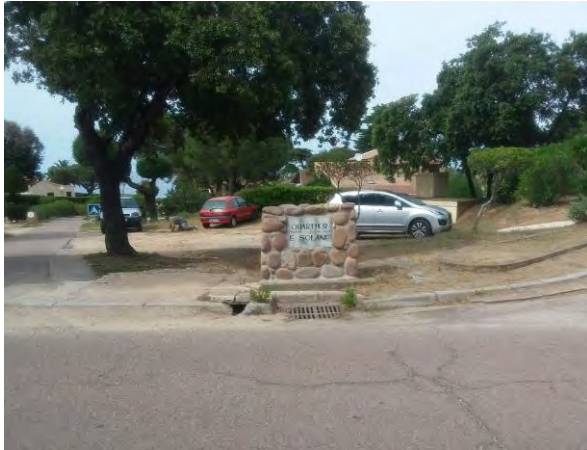
Avaloir avenue des Oliviers
