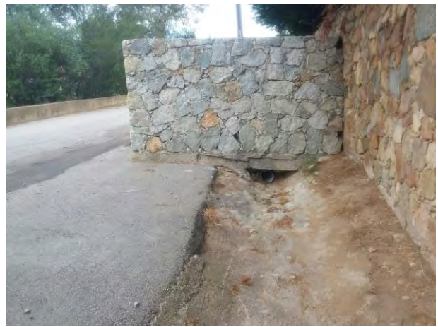
Aval local poubelle
