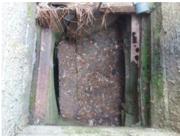
Seuil et obstruction Ø600
