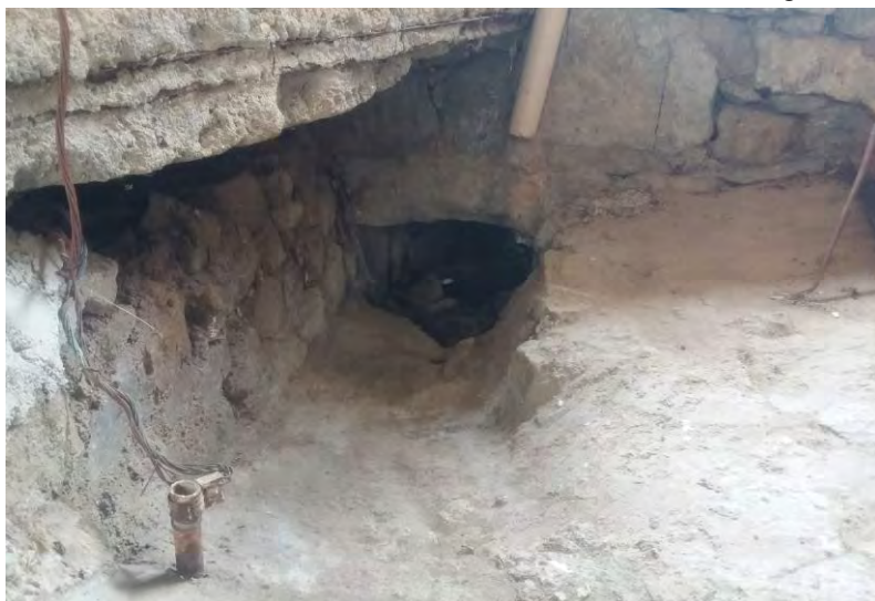
Tête amont de l'ouvrage hydraulique
