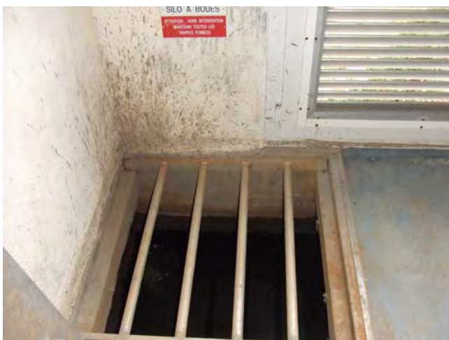
Silo à boues
