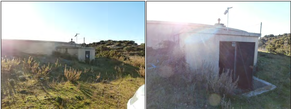
Figure 22 :Vues générales du réservoir
