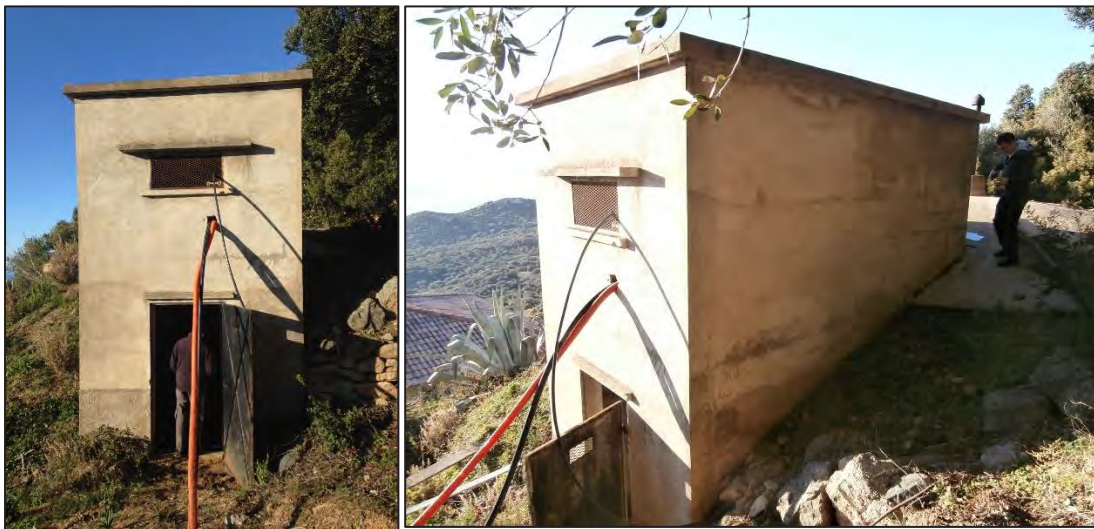
Figure 26 :Vues générales du réservoir
