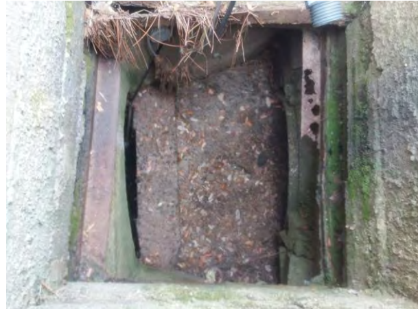
Seuil et obstruction Ø600
