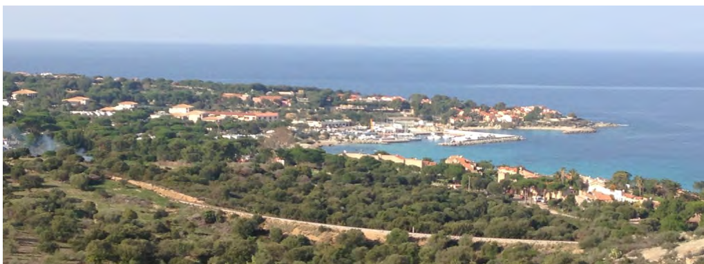
Photo ci-contre : secteur de Sant'Ambrogiu . Dans l'optique d'accueillir de nouvelles familles résidentes, la commune a développé dans ce secteur particulièrement bien desservi (port de plaisance, gares, accès direct à la RT), un projet immobilier d'accession à la propriété qui s'insère dans une dent creuse des espaces urbanisés.
