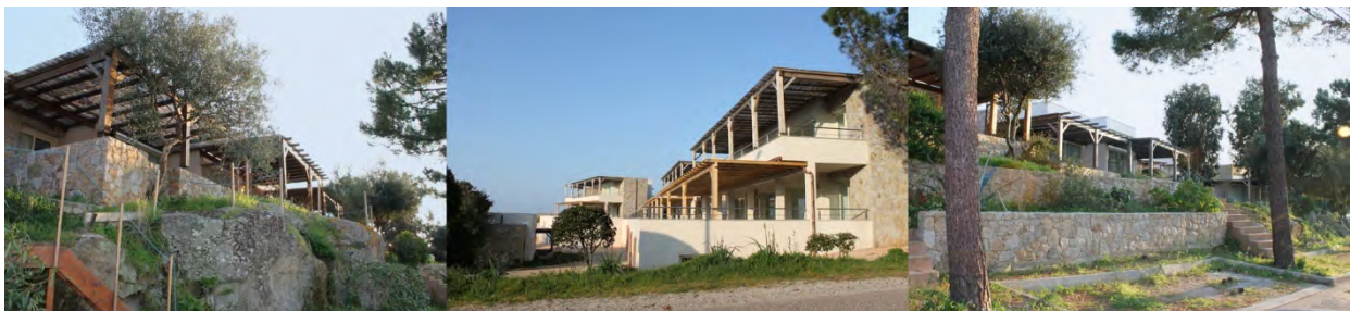
Nouvelles constructions valorisantes de la Marine
